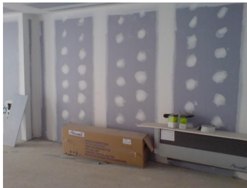
Figura 2. Material absorbente del interior de la cámara uniformemente colocado.
