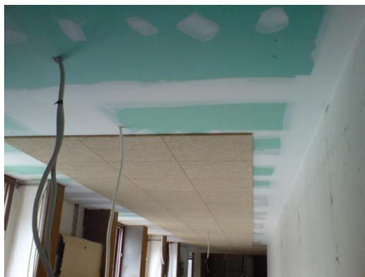
Figura 4. Puente térmico-acústico debido a que no se ha colocado material absorbente de forma uniforme en la cámara del techo suspendido.
