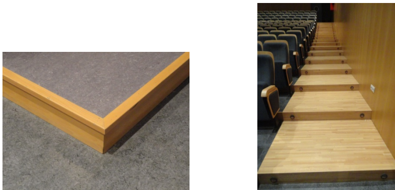
Imágenes 8 y 9. Contrachapado del suelo y de la tarima.
